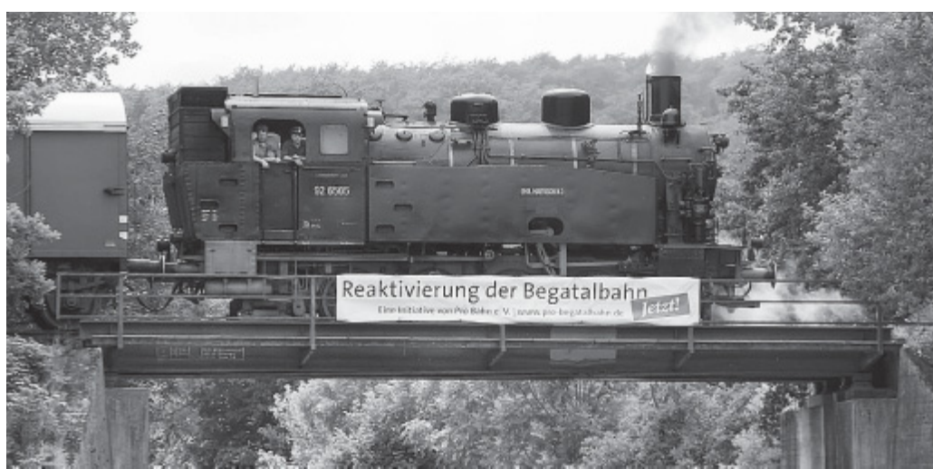
Finanzieller Kraftakt: Die notwendigen Instandhaltungs- und Sanierungsarbeiten, wie an dieser Brücke in Bega, kann der Verein dauerhaft nicht allein übernehmen.
